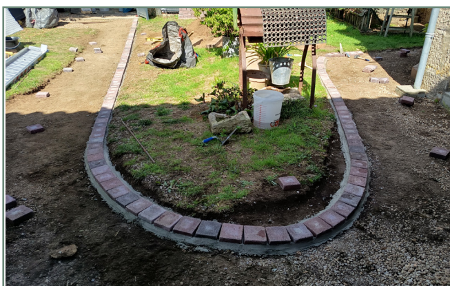
Pose d'une bordure en pavés pour une allée en gravier
